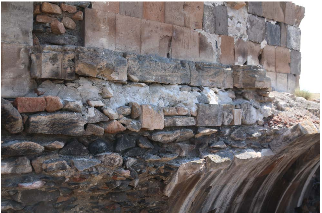
სურ. 23. ქართველთა ეკლესიის ჩრდილოეთი კედლის ძირის გაშიშვლებული წყობა და მასში ჩაყოლებული კვადრი (ხედი სამხრეთ-დასავლეთიდან)
